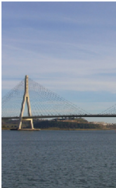
El puente Internacional del Guadiana une Andalucía con Portugal.
